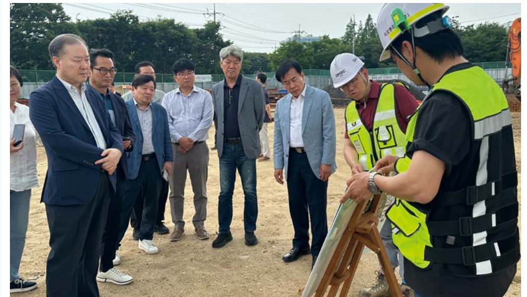
주요 시설·사업현장 방문(석남·가좌 우수저류시설)
